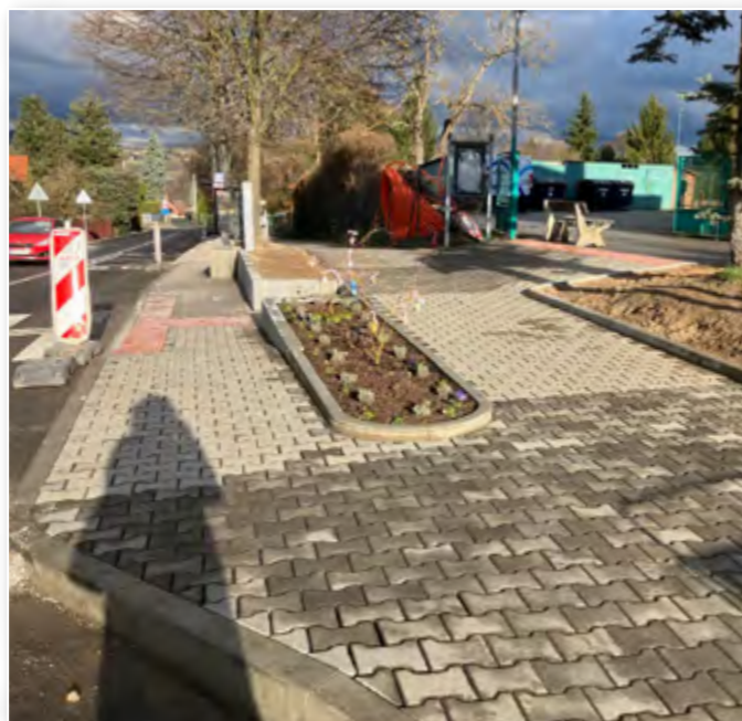
Přechod od hasičské zbrojnice ke středisku po rekonstrukci.
