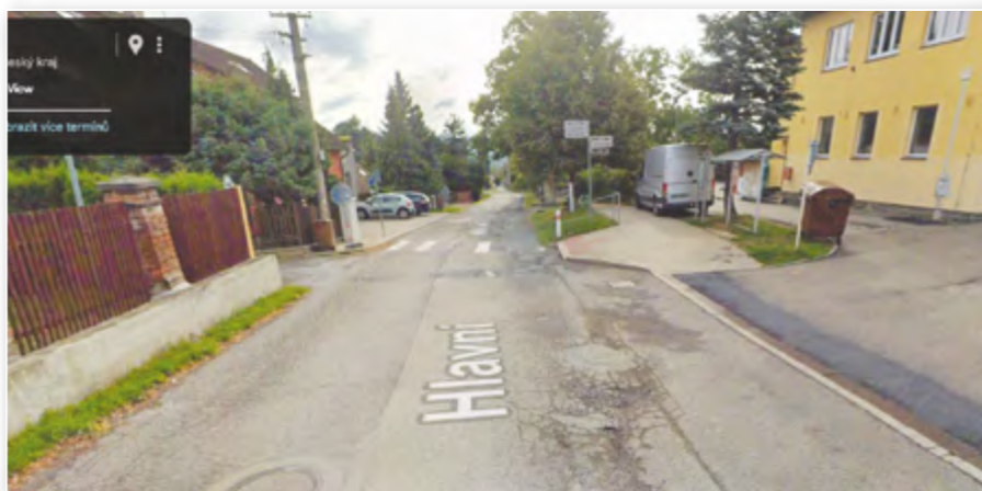
Přechod od hasičské zbrojnice ke středisku před rekonstrukcí.
