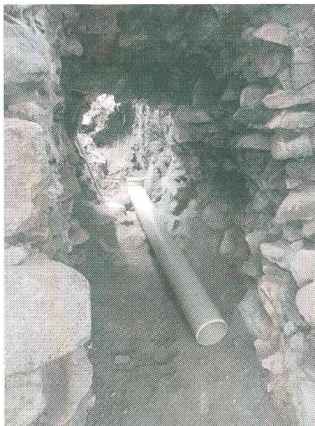
Odstranění starého bednění, odkrytí a vykopání, instalace odvodnění, a následné zazdění kaverny II.
