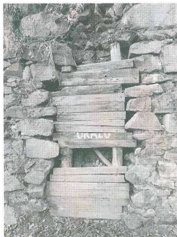
Odstranění starého bednění, odkrytí a vykopání, instalace odvodnění, a následné zazdění kaverny II.
