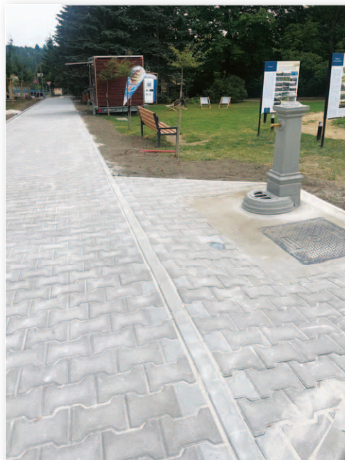
Nový chodník podél parku s nově instalovaným pítkem.
