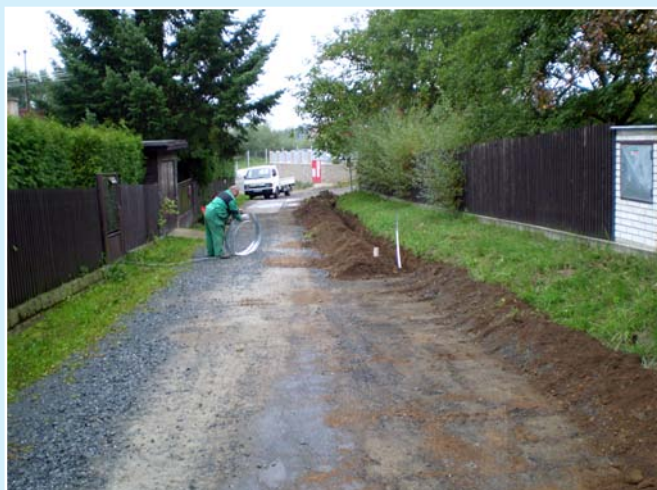
Výstavba veřejného osvětlení v ulici Pětihostská
