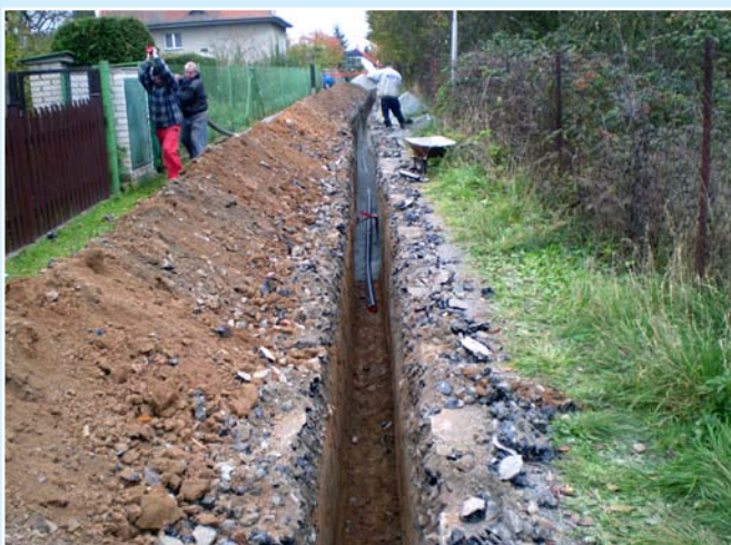
Výstavba vodovodu v ulici Krátká
