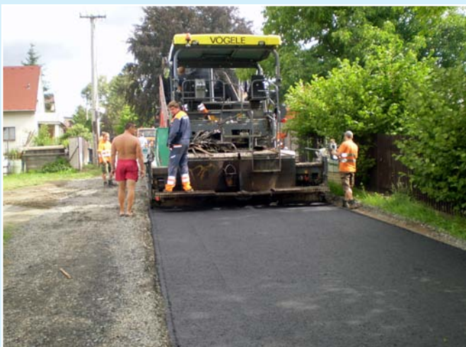
Pokládání asfaltového povrchu v ulici U Dálnice
