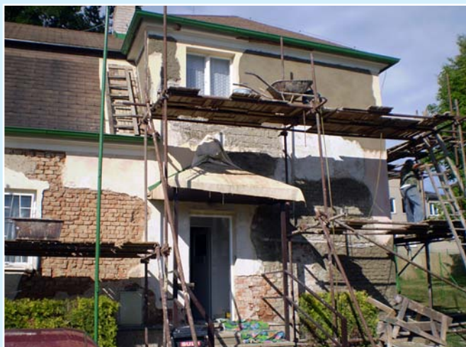
Oprava obecního úřadu
