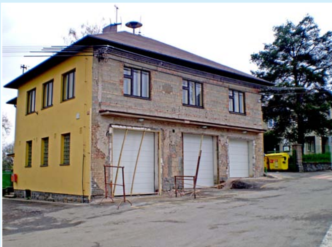
Oprava fasády včetně nátěru u hasičského domu
